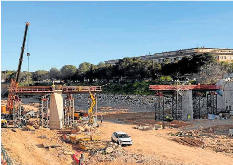
Una de las pasarelas en construcción en Picanya sobre el barranco del Poyo. JL BORT
