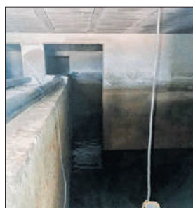
Depósito de distribución de la villa.
